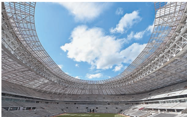
В марте строительство Большой спортивной арены планируется завершить.
