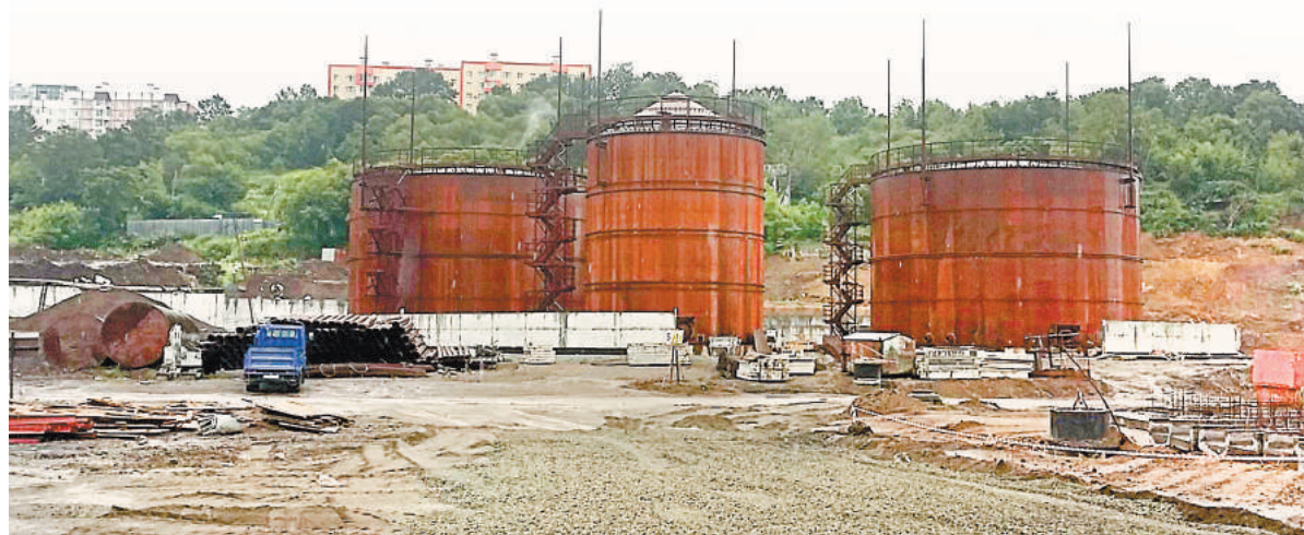
Строительство нефтеперевалочного комплекса из-за скандала приостановилось на 5 месяцев.
