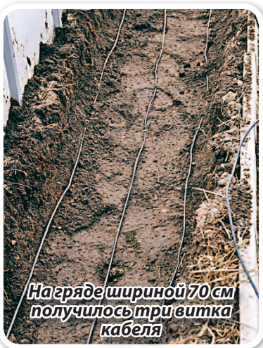
Металлическими шпильками прикрепил тепловой кабель
