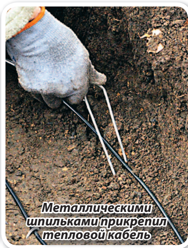
На гряде шириной 70 см получилось три витка кабеля
