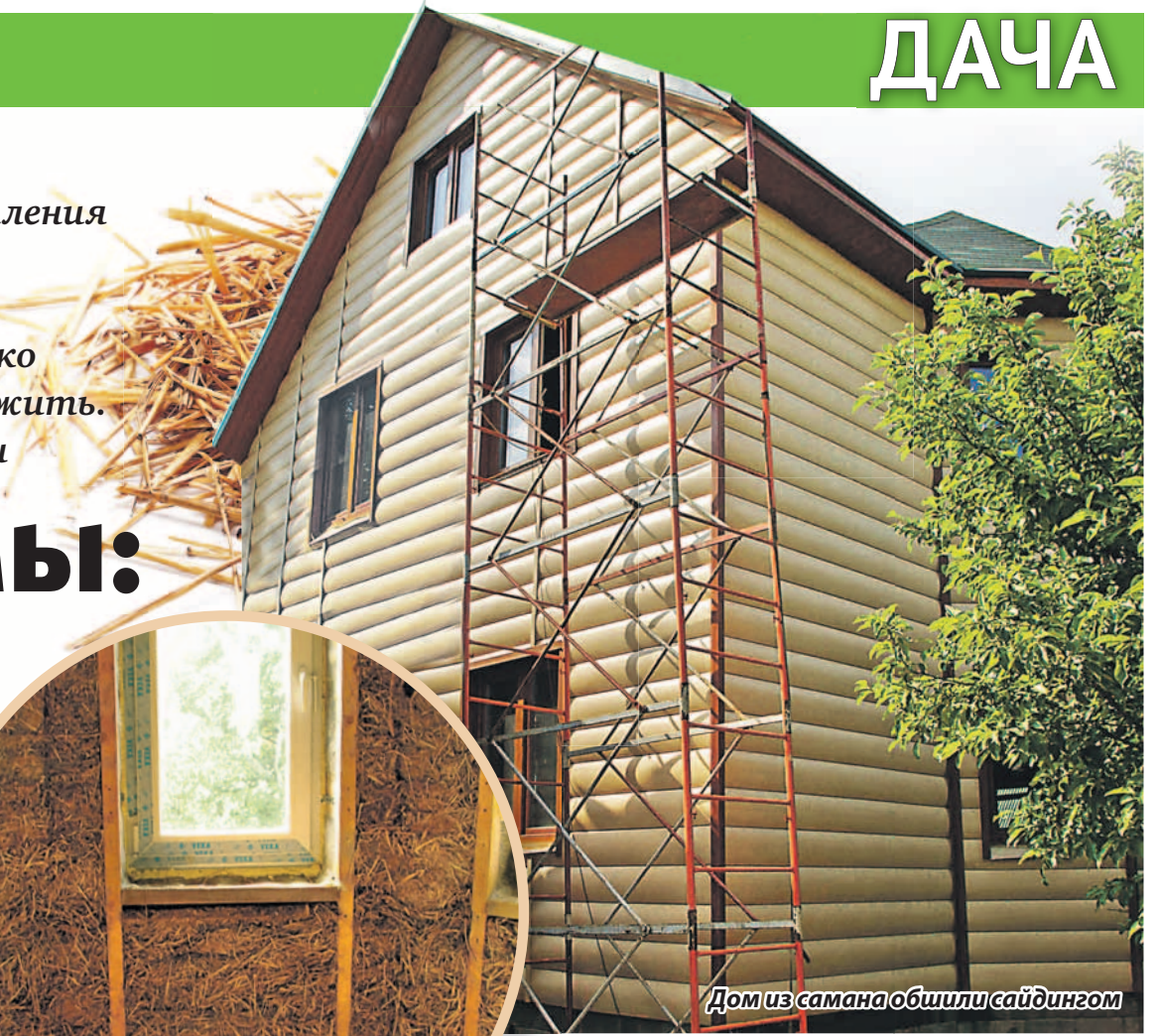
Саманные стены нужно хорошо просушить
