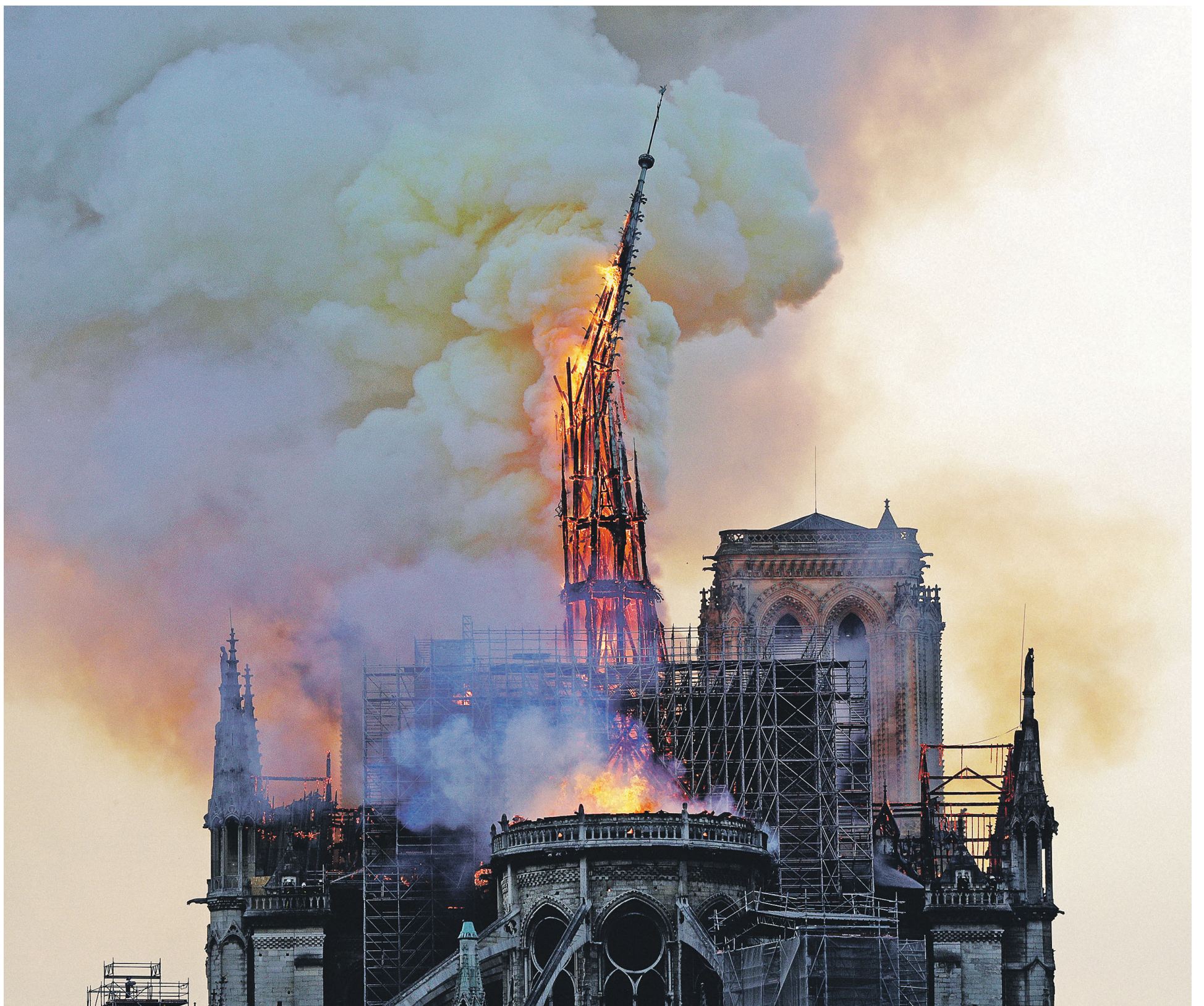
Во время пожара в соборе Парижской Богоматери рухнул шпиль и обрушилась крыша, часть исторического здания была полностью уничтожена
