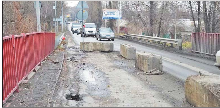
Ремонт Каменоломенского моста намечен на 2021 год.
