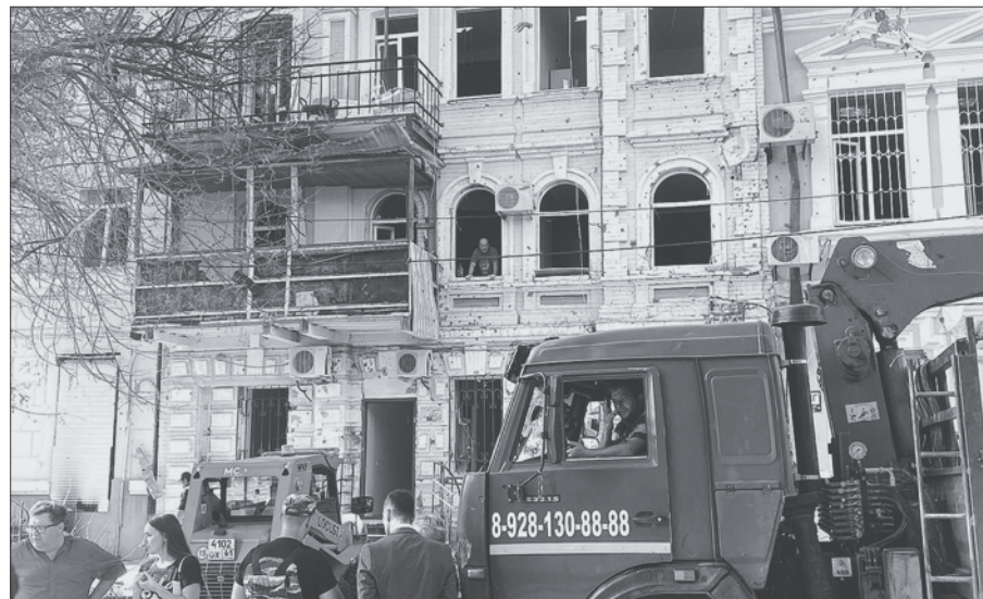
Жителям поврежденных домов вечером 7 сентября разрешили вернуться в квартиры.
