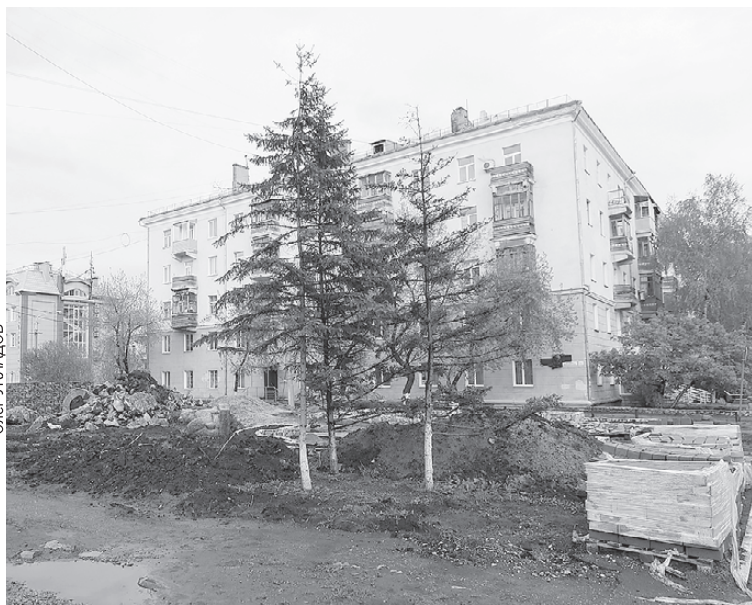
На пересечении Ленина - Кирова вовсю идут работы по благоустройству.
