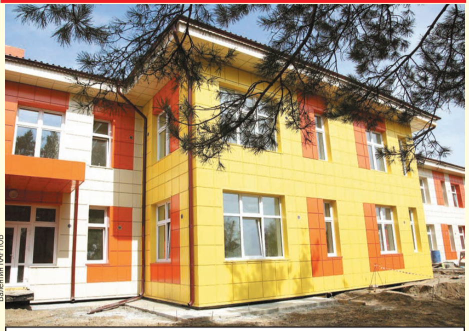
Современный детсад на станции Батарейной практически готов.
