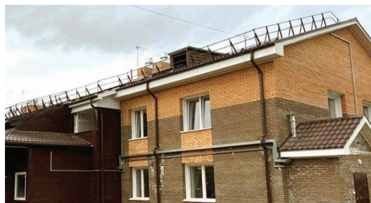
Новые дома возводят в микрорайоне Угольщикова.
