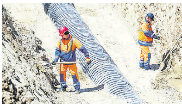
Компания обеспечит микрорайон дорожной и инженерной инфраструктурой.
