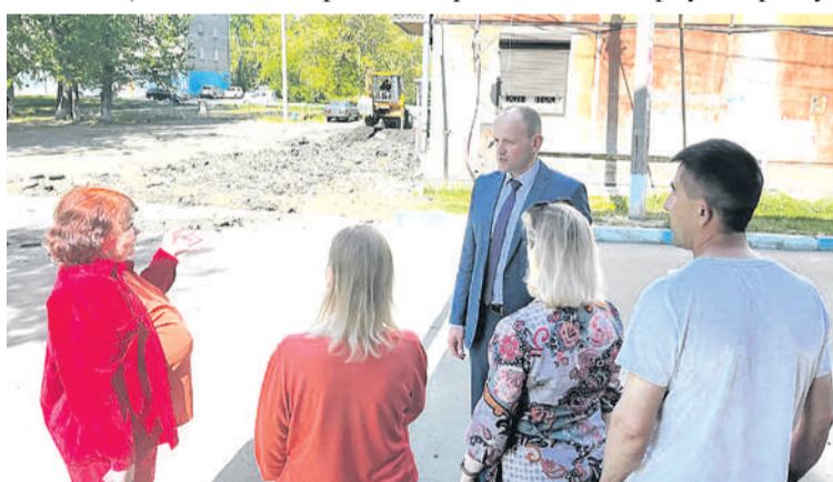
Благоустройство двора по адресу: пер. Восточный, 2.
