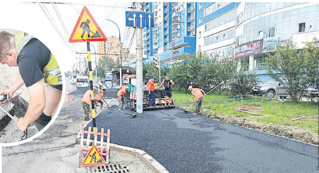
Во время дорожного ремонта обновляют и тротуары.
