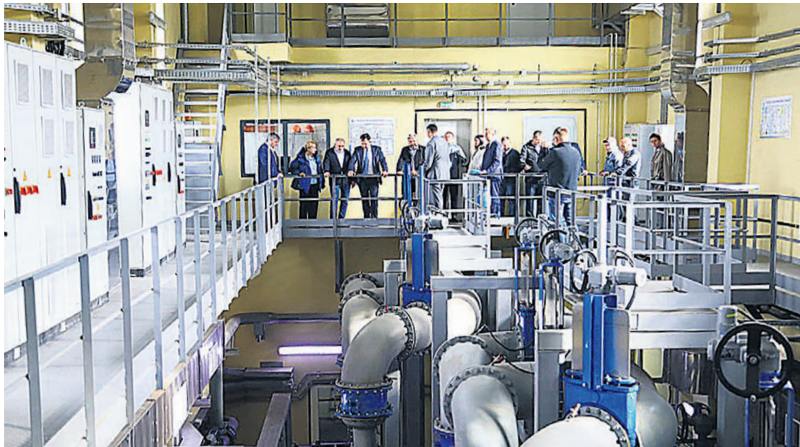
Масштабная работа по замене оборудования КОС правого берега завершается, на очереди - КОС левого берега.
