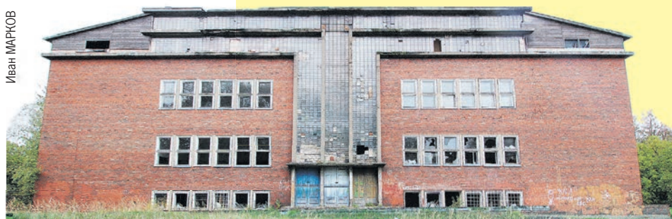
Здание пустует и разрушается с 2012 года.
