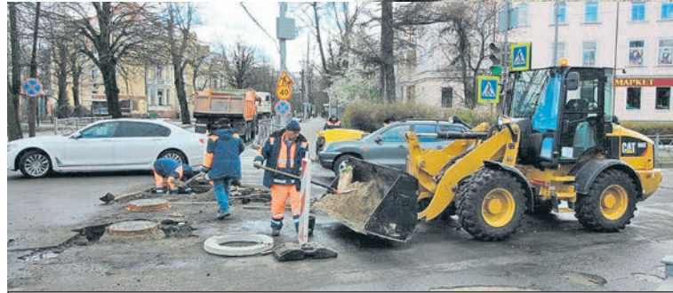
Дорожным рабочим изолироваться не рекомендовали, поэтому ремонт на опустевших улицах продолжается.
