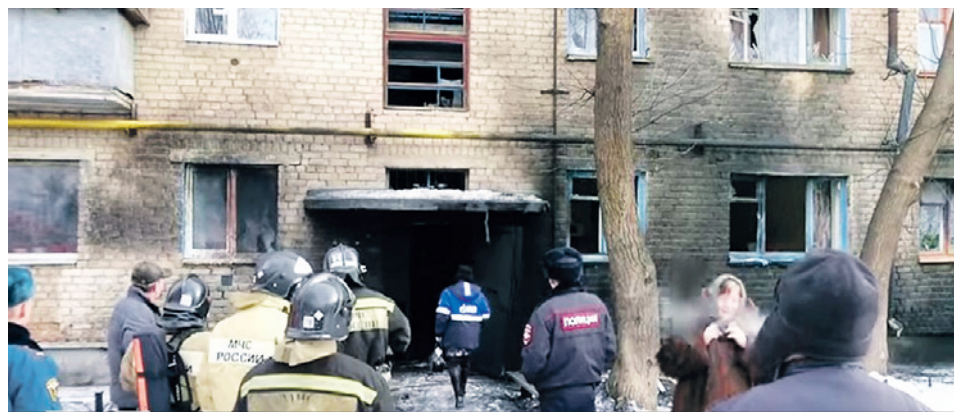
В четырехэтажном доме коммунальщики проводили сварочные работы.
