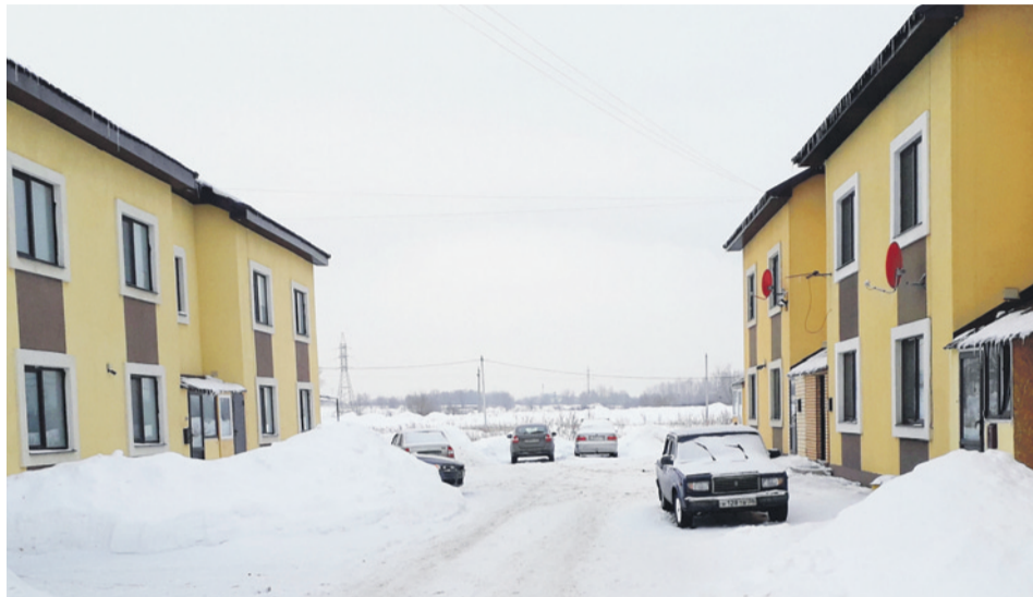
Четыре квартиры администрация Оренбурга выкупила для предоставления жилья переселенцам из ветхого жилья.
