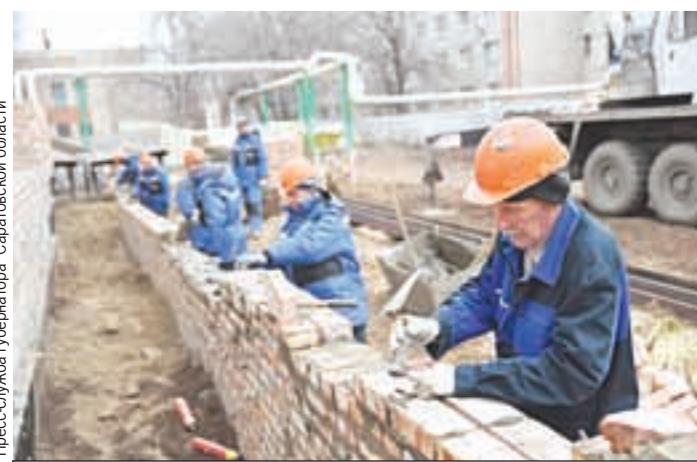
Строительство школы в Приволжском идет по графику.
