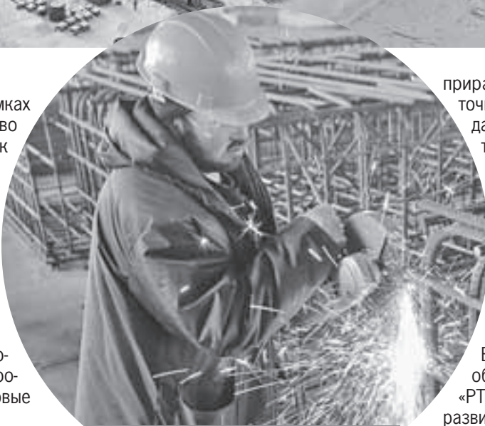
Монтаж оборудования на высокотехнологичном предприятии - дело тонкое.
