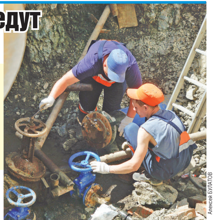
Работы запланированы на 11 участках теплотрасс.
