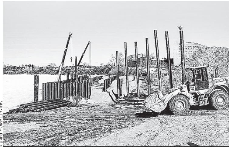
Строители укрепляют берег Туры от улицы Астраханской до аквапарка «ЛетоЛето».
