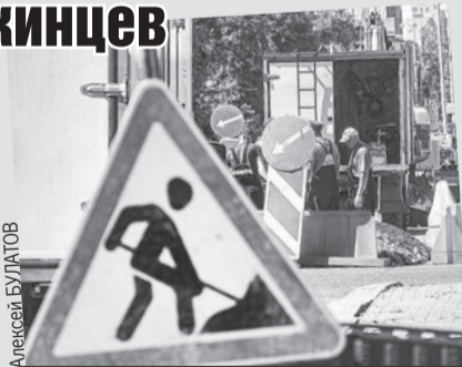
Дорожники приступят к ремонту в начале апреля.
