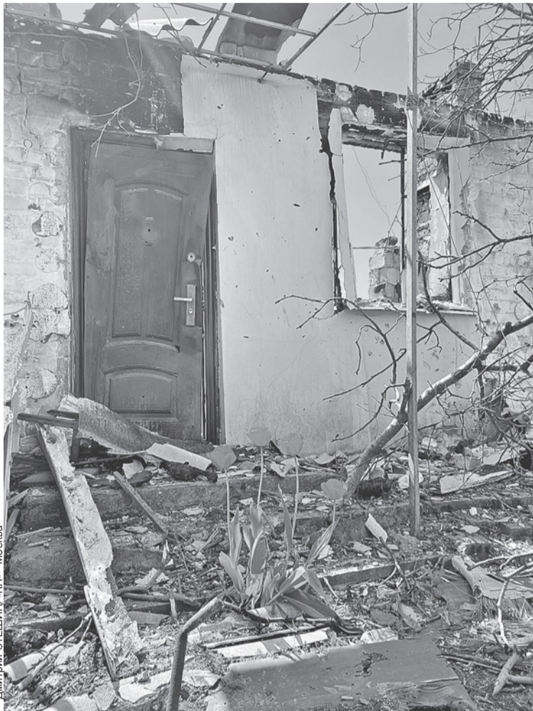
За стальной дверью - руины от постоянных обстрелов, а перед ней - тюльпаны майского Мариуполя, которые пробились через прах и хаос.
