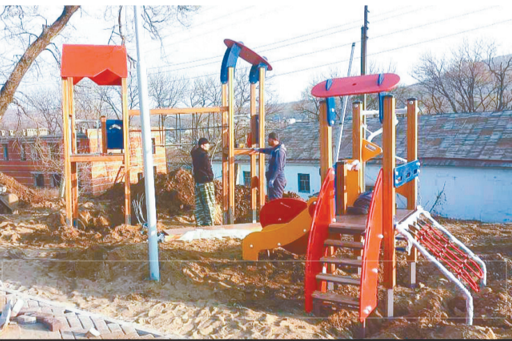
В сквере уже завершаются работы по укладке брусчатки, монтируются спортивная и детская площадки.
