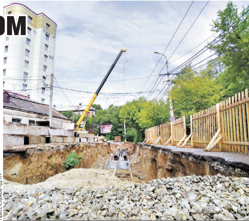
Работы на улице Синельникова.
