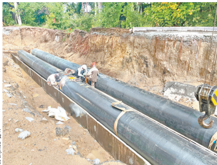
Сроки монтажа предизолированной трубы меньше, чем классической.
