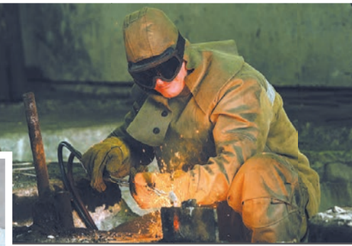
Сотрудник Приморской ГРЭС проводит сварочные работы.
