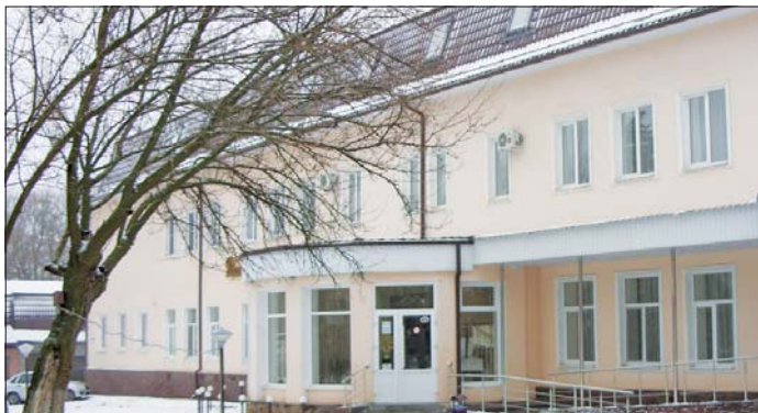
Так выглядит здание, в котором располагалась шахтинская городская баня.
