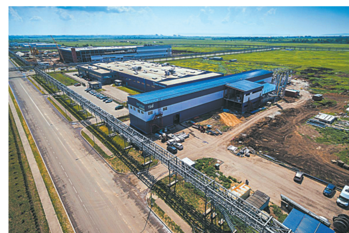
Значительным подспорьем резидентам стали готовые инженерные сети, построенные за счет бюджетных средств.
