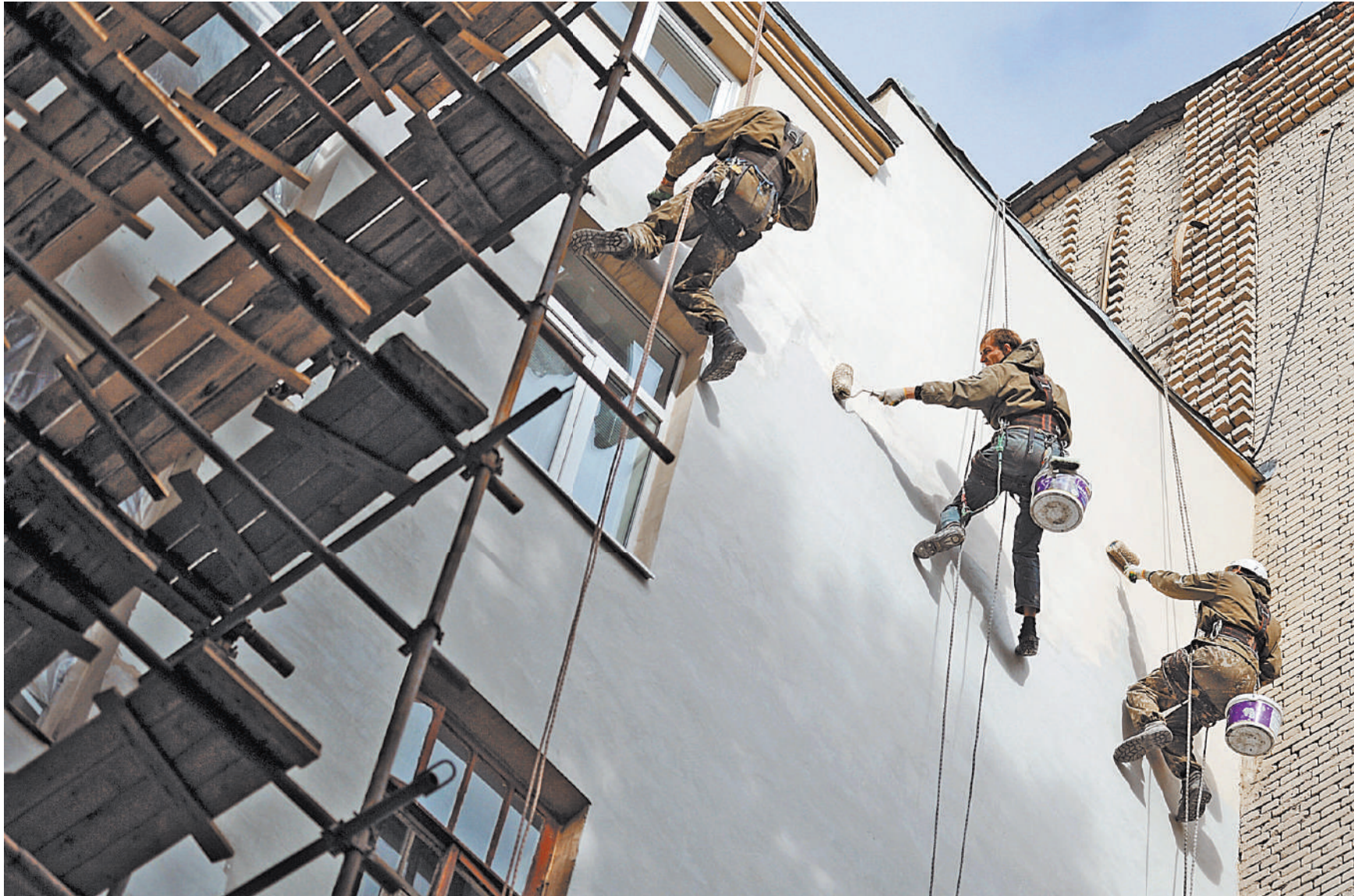
После ремонта фасадов по современным технологиям, которые сейчас применяются в столице, многие жилые дома начинают выглядеть лучше новых.
