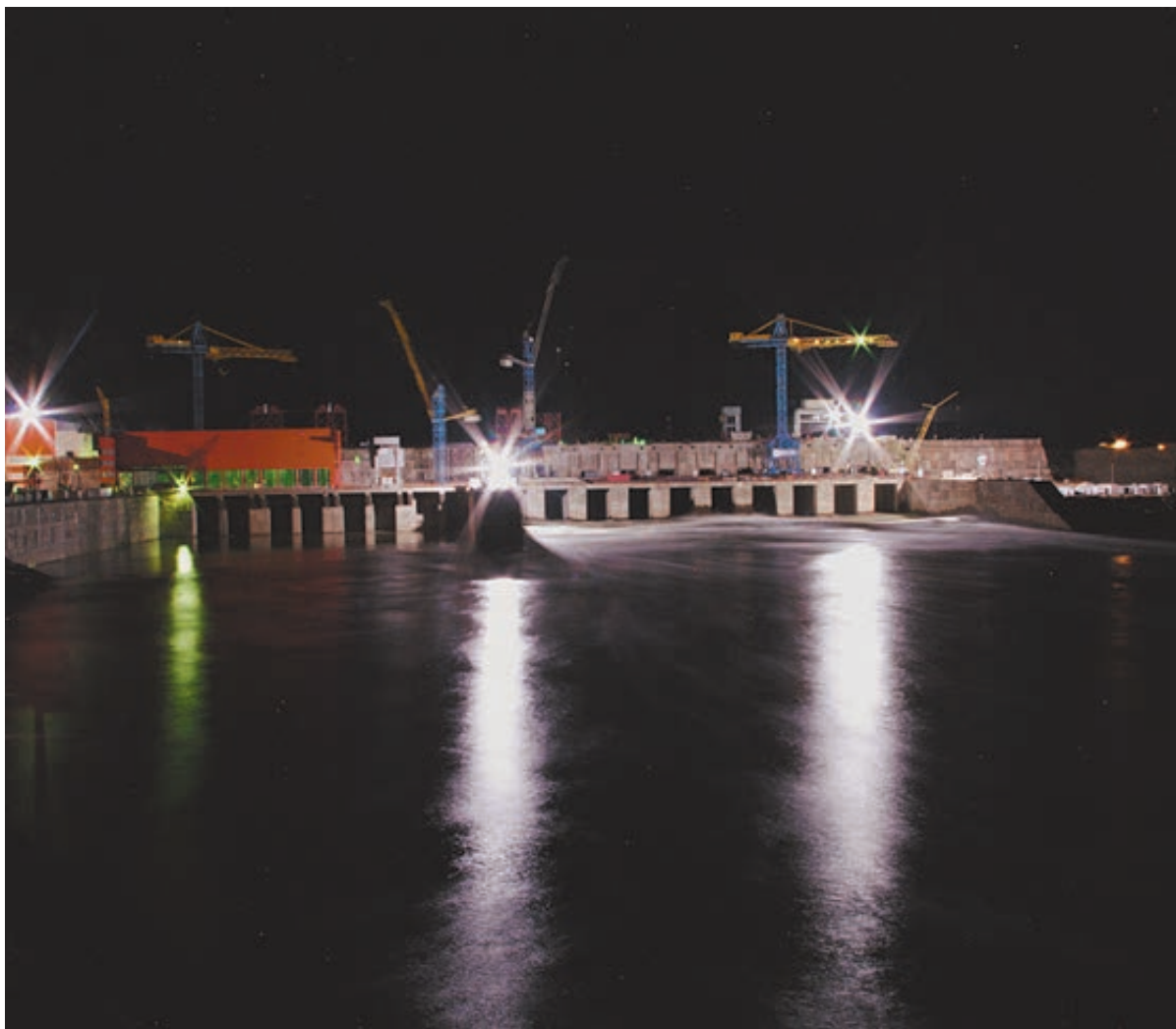
На строительстве Усть-Среднеканской ГЭС.
