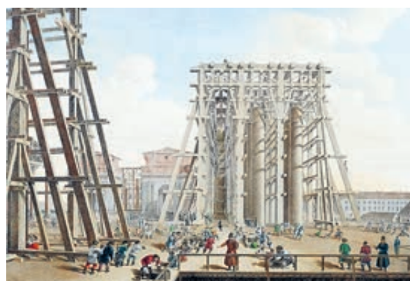
Строительство и освящение Исаакиевского собора.
