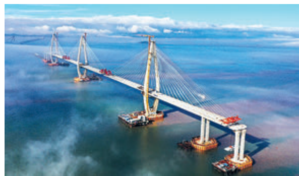
В провинции Чжэцзян идет строительство морского моста Нинбо – Чжоушань.
