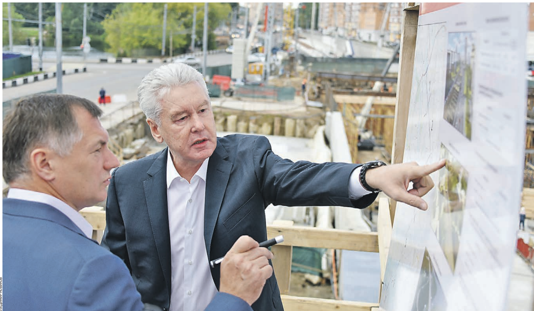
Вчера 11:37 Мэр Москвы Сергей Собянин (справа) и заместитель мэра Москвы по вопросам градостроительной политики и строительства Марат Хуснуллин осматривают ход работ на Большой Академической улице, которая станет частью центрального ядра Северо-Западной хорды
