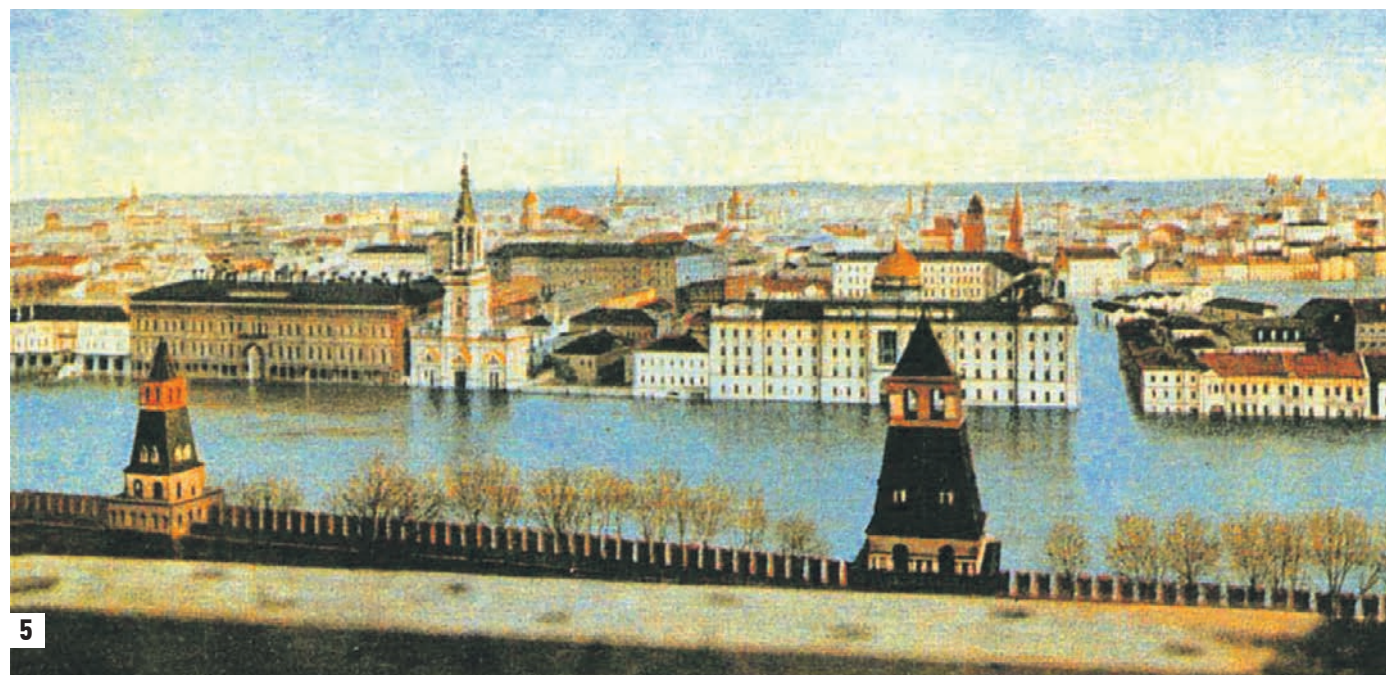
1965 год, спасение пассажиров на реке Неглинке (1) Вчера 11:44 Улица Неглинная. Замначальника технического управления Мосводосток Александр Захаров показывает, какой уровень воды был здесь в 1965 году (2) Август 1959 года. Под воду погрузилась Трубная площадь. Юный москвич «утонул» практически по пояс (3) Дом на пересечении 4-го Голутвинского переулка и Якиманской набережной хранит воспоминание о великом московском наводнении 11 апреля 1908 года, когда только лишь за сутки вода в Москве-реке поднялась на рекордные 9,35 метра (4) Раскрашенная вручную фотография наводнения 1908 года. Вид на Софийскую набережную из Кремля (5)
