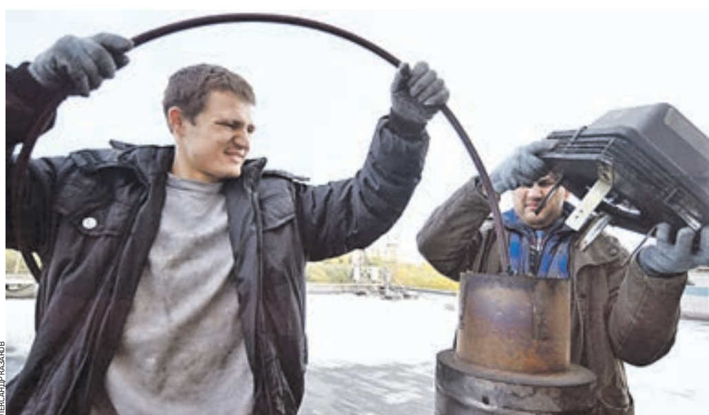
Вчера 8:30 Трубочист Егор Царев (слева) прочищает дымоход печи ресторана с помощью троса и ерша. Игнат Костин (справа) руководит действиями начинающего специалиста
