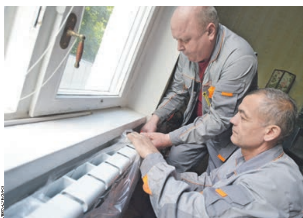
Вчера 11:40 Рабочие Юрий Саренко (слева) и Исмаил Абдулаев устанавливают новую современную батарею в одной из квартир дома на улице Академика Павлова
