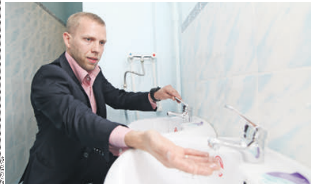
Вчера 14:10 Замдиректора дошкольного отделения школы № 1363 Игорь Недошкин проверяет исправность сантехники, замененной во время текущего ремонта
