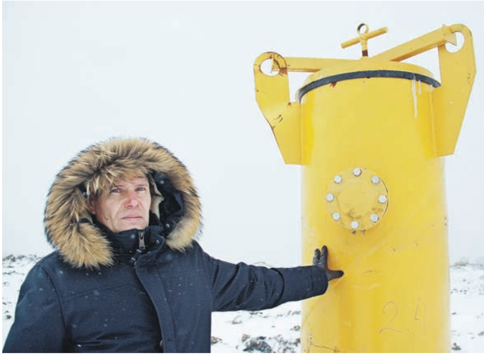
Вчера 13:10 Заместитель директора по строительству организации, которая занимается рекультивацией полигона «Кучино», Вадим Дьяконов показывает часть системы газоотводных трубопроводов, установленных на рекультивируемом объекте
