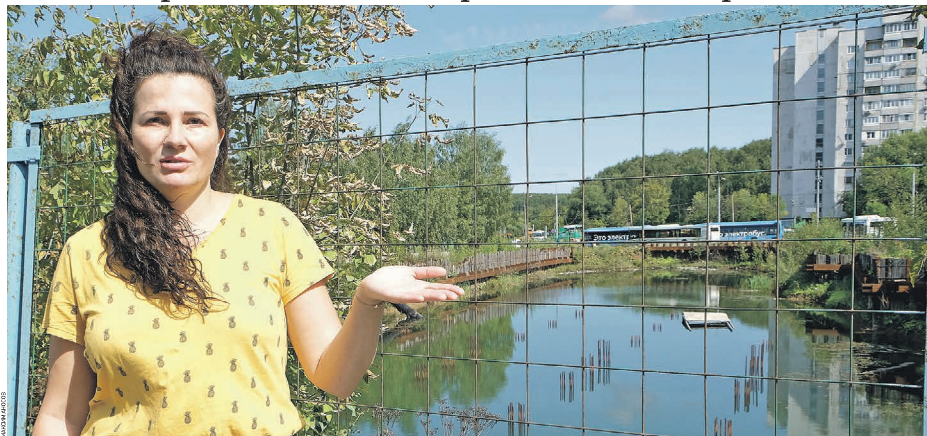
11 августа 13:40 Местная жительница Наталья Чащилова показывает состояние заброшенного котлована, который образовался после того, как стройку заморозили. В прошлом году здесь решено возвести спортивный объект для горожан
