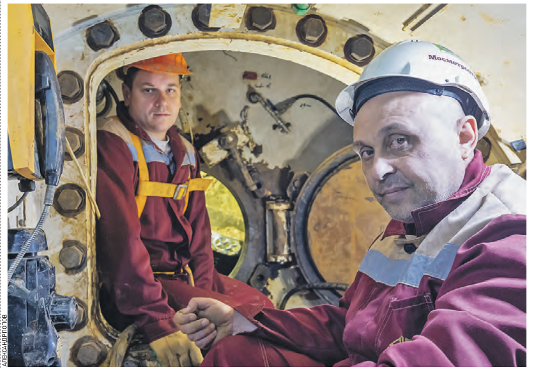
24 июля 2021 года. Машинист шита Андрей Шибавев (справа) и машинист блокукладчика Сергей Печенин во время прокладки тоннеля Люблинско-Дмитровской линии метро
