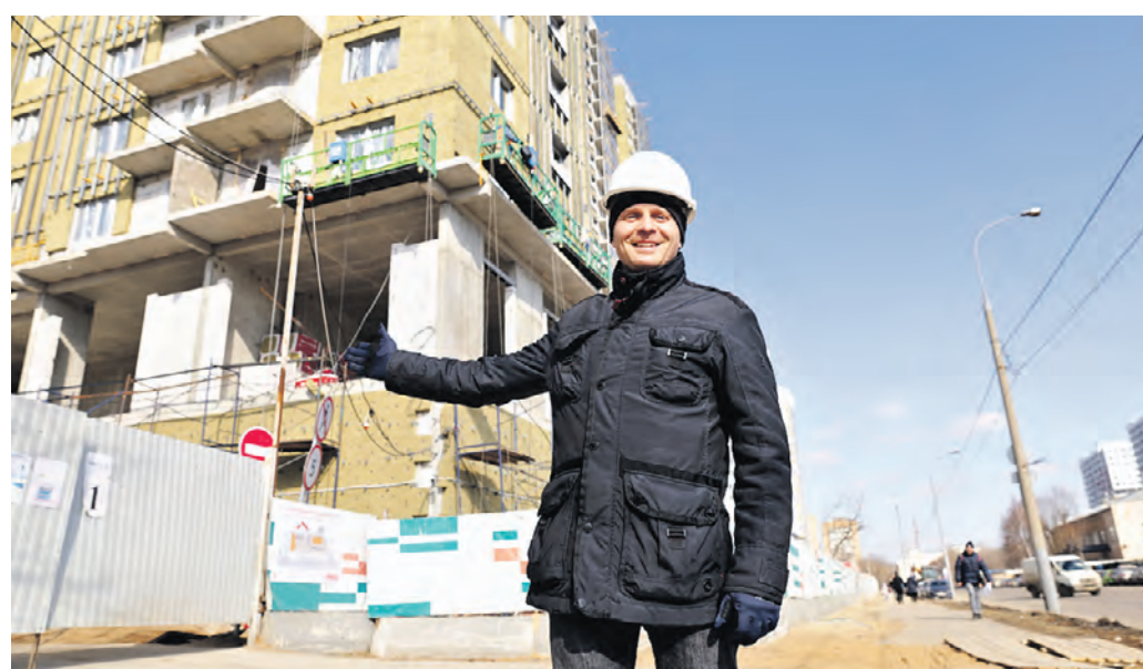
16 июня 2022 года. Руководитель проекта Николай Лавров показывает ход строительства дома по реновации в Нагатинском Затоне. Темпы ввода жилья будут расти
