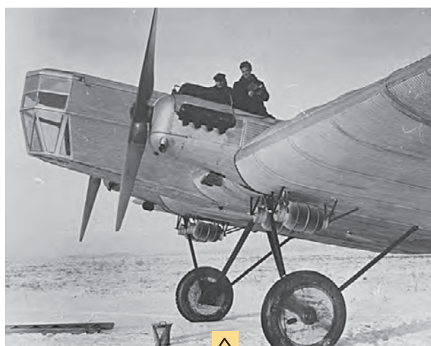
Бомбардировщик Туполев АНТ-4 первый в мире серийный двухмоторный бомбардировщик, фото 1925 года
