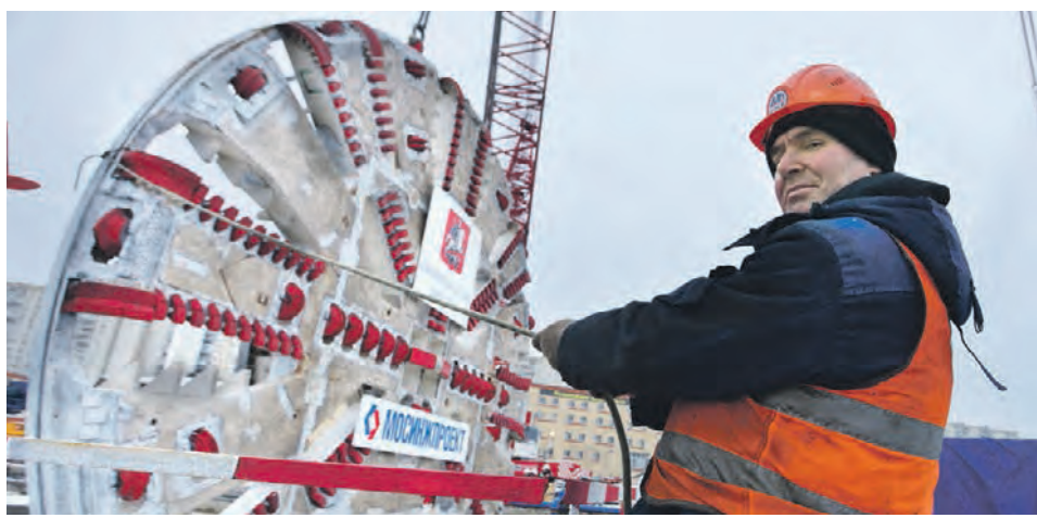
► 23 декабря 2016 года. Механик участка Анатолий Гришин на подготовке 10-метрового щита
