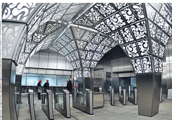
6 июня 2018 года. Вестибюль строящейся станции метро «Новопеределкино»
