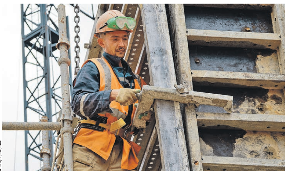
Сотрудники ГАУ «НИАЦ» регулярно проводят нормативные наблюдения на строящихся объектах столичного метро
