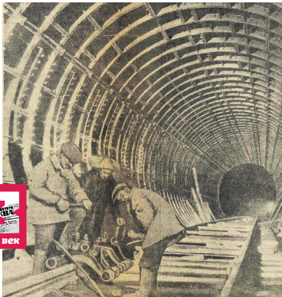
1937 год. Термитная сварка стыков рельсов в тоннеле шахты № 55. Такие стыки нужны, чтобы уменьшить шум от движения поездов в тоннелях из чугунных колец
