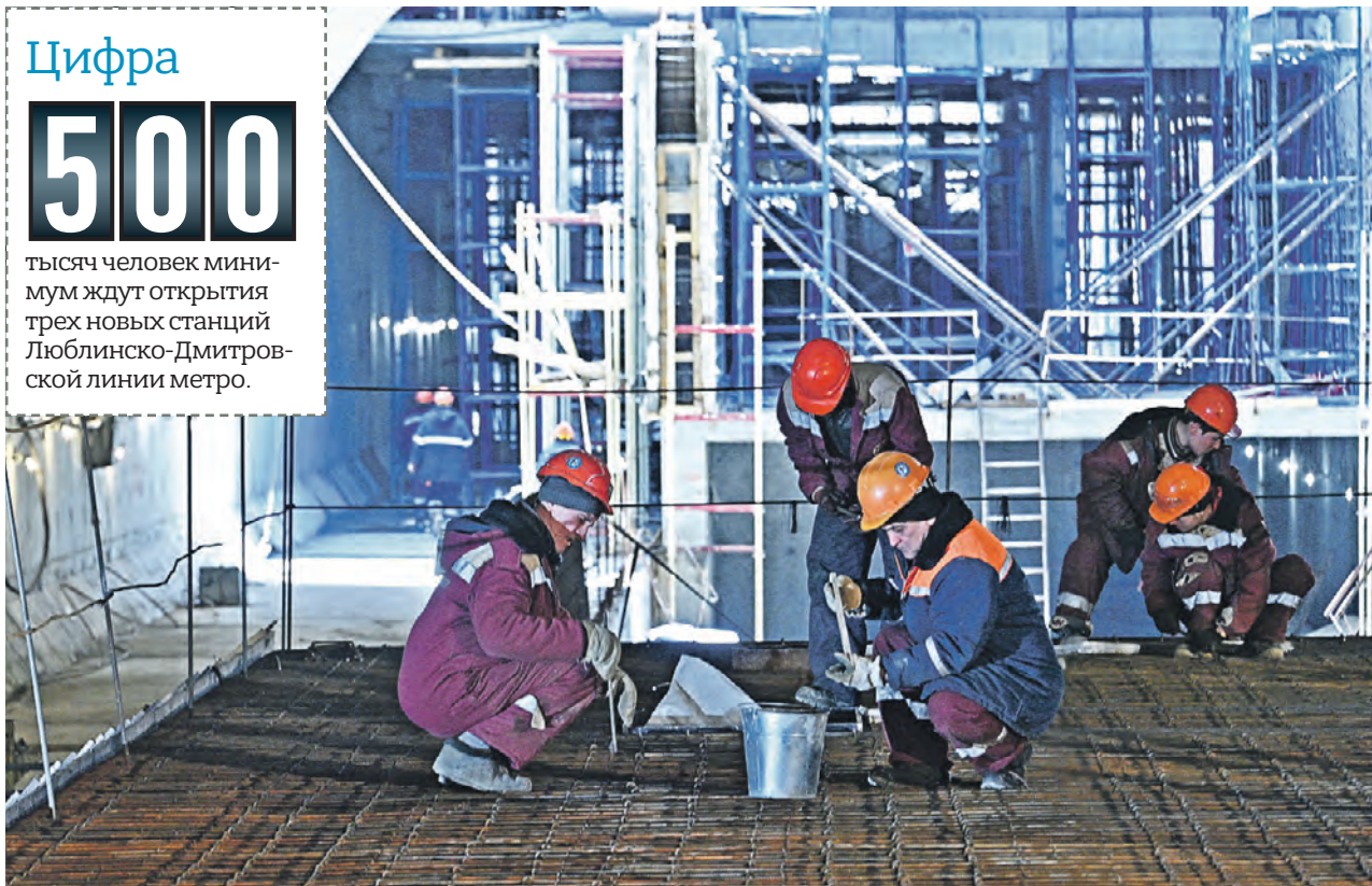
14 апреля 2023 года. Метростроевцы работают на станции метро «Физтех» Люблинско-Дмитровской линии
